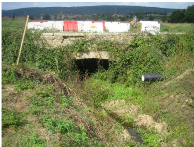
Foto 4 - Ponte sulla SC delle Volte (vista da monte) (sezione 26,2)
