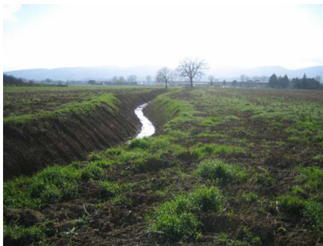
Foto 5 - Tratto a valle del ponte sulla SC delle Volte (sezione 22)
